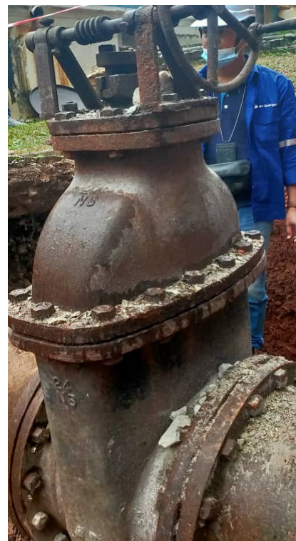
Katup berusia 95 tahun yang berfungsi penuh, digali dari tanah di Bukit Nanas, Kuala Lumpur, Malaysia.
